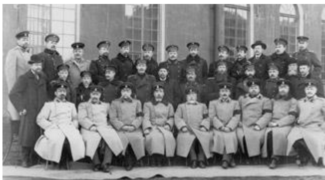
Группа высшего офицерского состава перед зданием завода. 1900-е годы. Фото Карла Буллы
