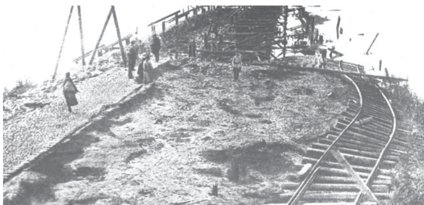
У Лахтинской дамбы, разрушенной водой
