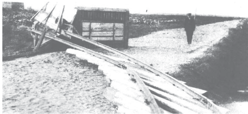
Приморская железная дорога (изображены смытые с насыпи рельсы)
