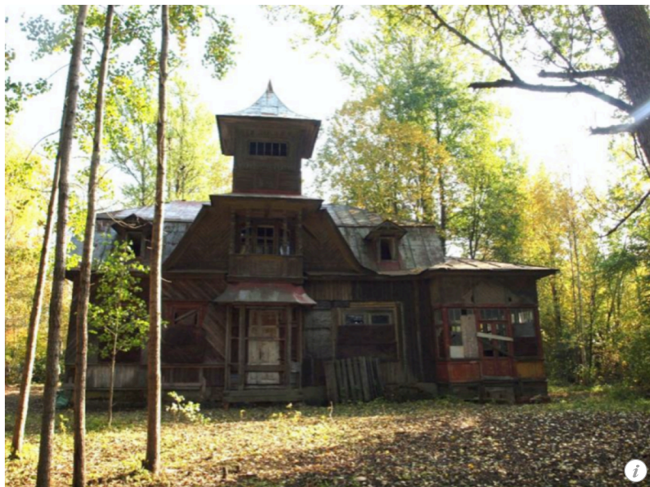
Общий вид здания с улицы Чкалова. Фото выполнено до консервации объекта в 2020 году
