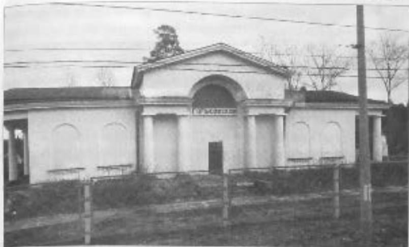
Станция Горьковская. Новый вокзал. 2013 г.
