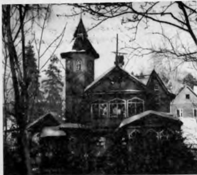
Дом на Школьной ул. 6.
