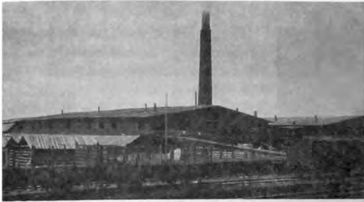
Кирпичный завод кн. Вяземской. Открытка начала XX в.
